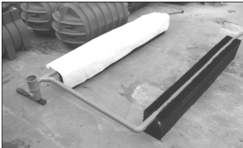
Conexión de un segundo tramo de drenaje a la tubería/cámara de control de muestras.
